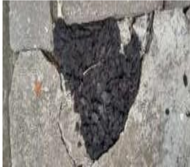
Gambar 7. Aspal karet dari campuran aspal, karet, pertasol dan kerikil.
